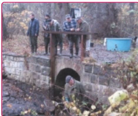
Myslivci při výlovu rybníka U Kamenného stolu (jezíčko v Oboře).
