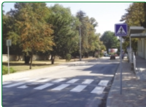
23. 9. 2009 Byl vybudován nový chodník v Chaltické ulici s autobusovou zastávkou
